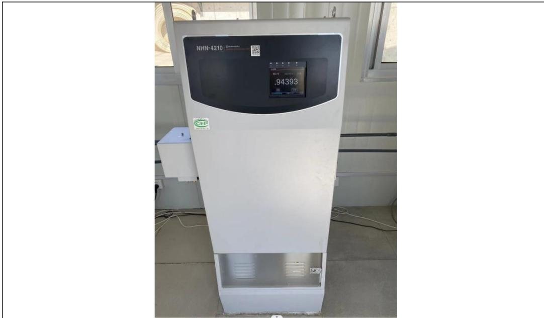
图 4.2-5 废水在线监测仪安装情况
